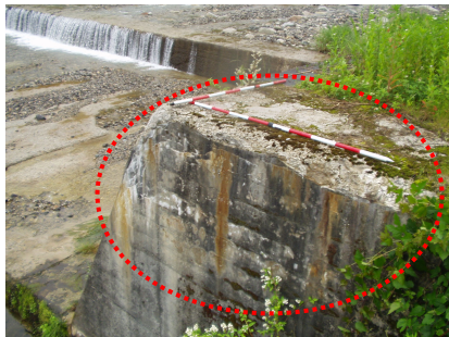
アルカリ骨材反応の状況
