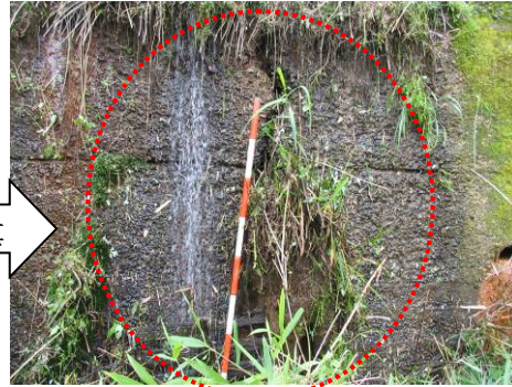
下: 鉛直方向の亀裂 堤体中央部, 水通し～下流のり面に, 鉛直方向の亀裂が生じている。
