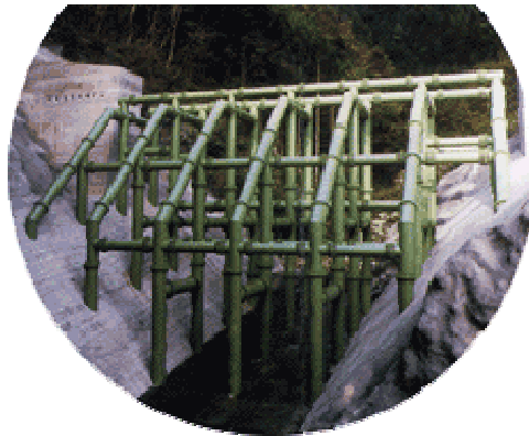
格子型砂防堰堤
