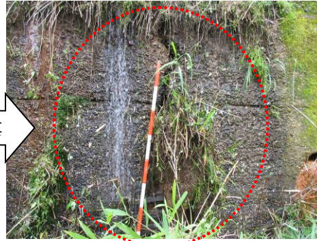
下：鉛直方向の亀裂 堤体中央部，水通し～下流のり面に，鉛直方向の亀裂が生じている。
