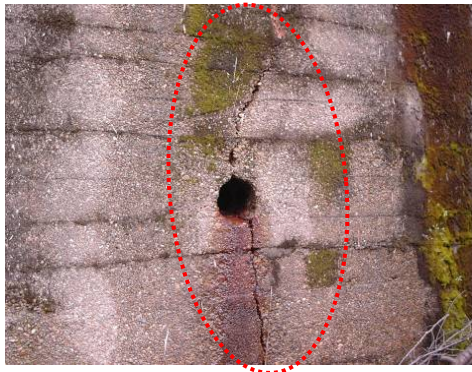
打ち継目に沿った亀裂の状況 基礎地盤の流失に伴い堤体下部が沈下して，堤体下流のり面に亀裂が生じている。
