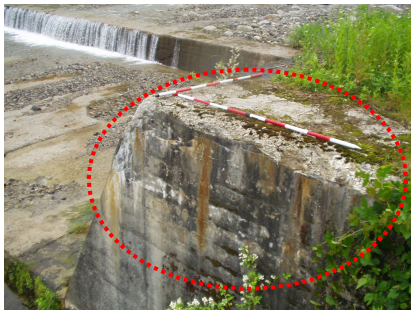
アルカリ骨材反応の状況
