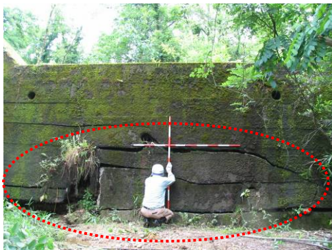
打ち継目に沿った亀裂の状況 基礎地盤の流失に伴い堤体下部が沈下して，堤体下流のり面に亀裂が生じている。
