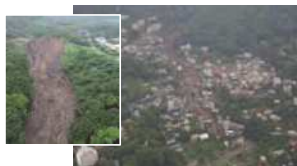
R37 静岡県熱海市 死者28名、住宅被害98棟
