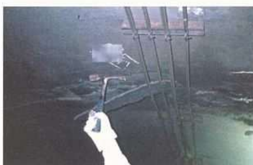
付写真-2.4.5 補修モルタルが劣化してはく離している例
