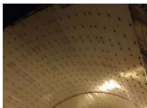
付写真-2.4.6 鋼板接着（左）・繊維シートの接着（右）例
