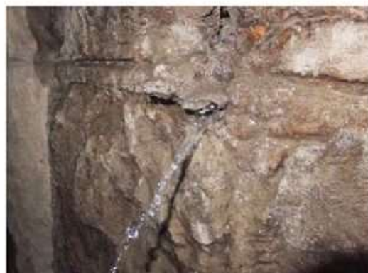
付写真-2.4.3 漏水（噴出）している例
