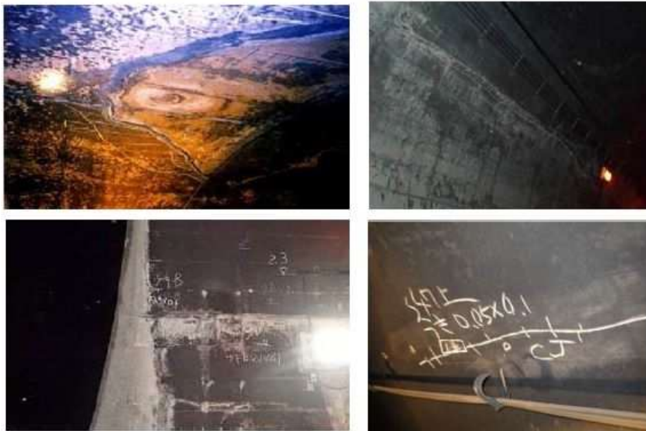
付写真-2.4.7 コールドジョイント付近に発生したひび割れの例
