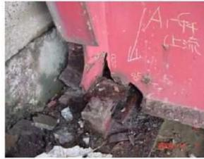
地震により断面欠損している箇所が破壊され、主桁が荷重支持できなくなった例
