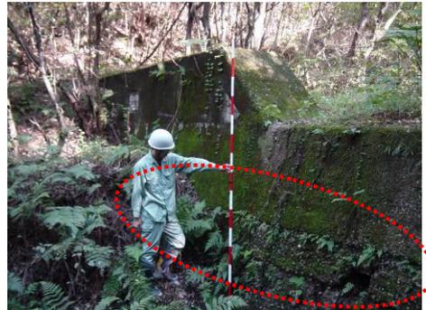
打ち継目亀裂に沿った風化・欠落
