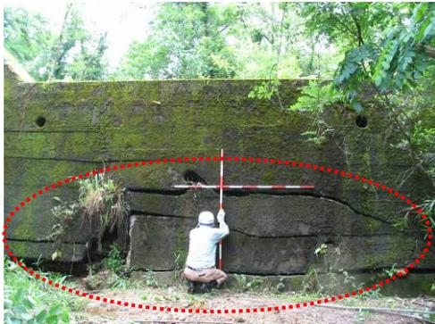
打ち継目に沿った亀裂の状況
