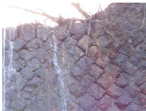
合端コンクリートの欠損
