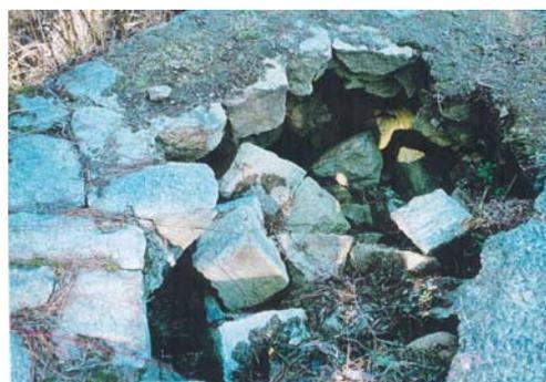
天端の陥没（中詰の吸出し）
