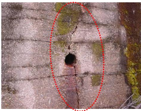
左：鉛直方向の亀裂
