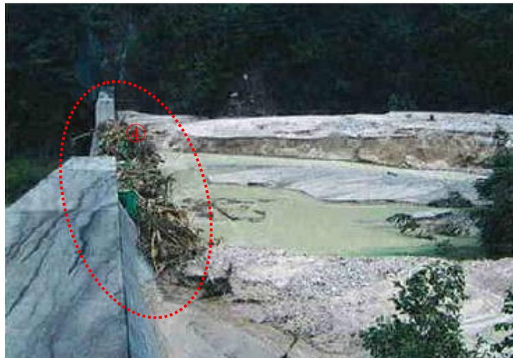
主堰堤 (流木止め) が流木を捕捉したままの状態
