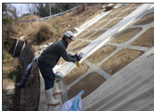
< 遠隔実地検査（現場側） >
