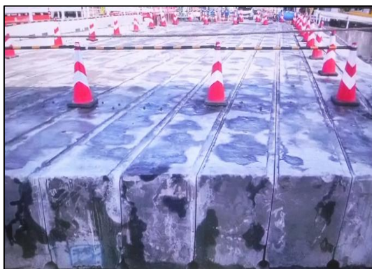
<遠隔実地検査（検査員の映像）>
