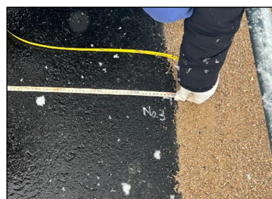
<現場実地検査>
