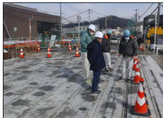
<現場実地検査>
