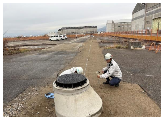
<遠隔実地検査（現場側）>
