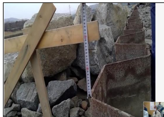
＜遠隔実地検査（検査員の映像）＞
