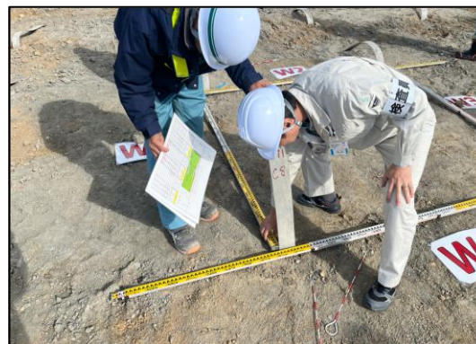
＜現場実地検査＞
