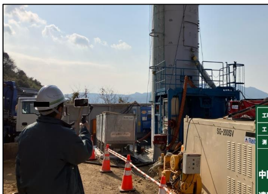
<遠隔実地検査（現場側）>
