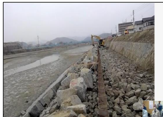
＜遠隔実地検査（検査員の映像）＞
