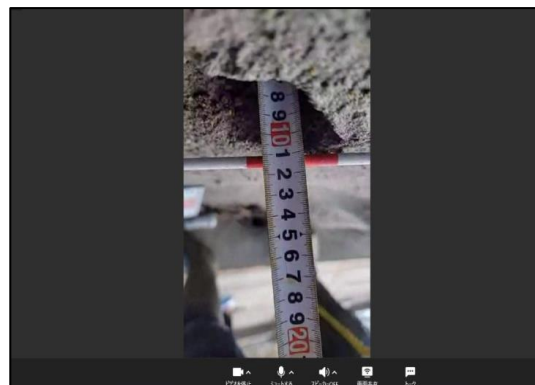
<遠隔実地検査（検査員の映像）>
