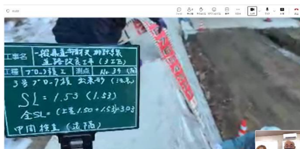
<遠隔実地検査（検査員の映像）>
