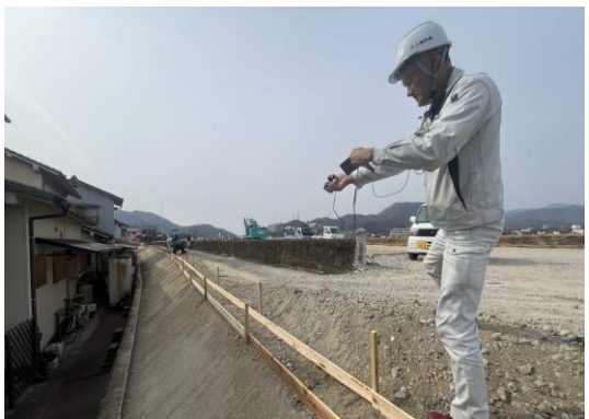
< 遠隔実地検査（現場側） >
