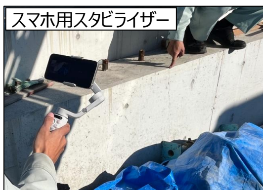
＜遠隔実地検査（現場側）＞
