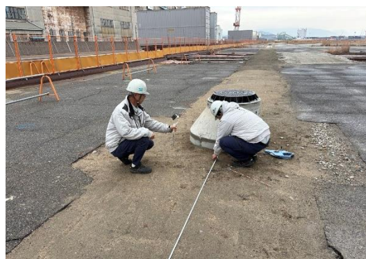
<遠隔実地検査（現場側）>
