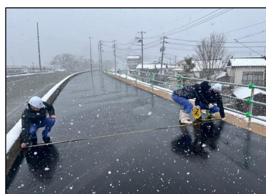
<遠隔実地検査（現場側）>
