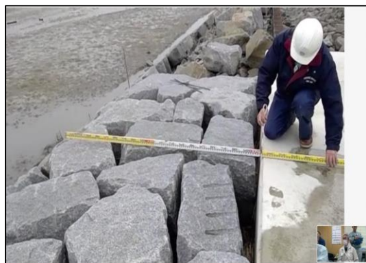
＜遠隔実地検査（検査員の映像）＞
