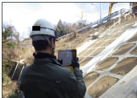
< 遠隔実地検査（現場側） >
