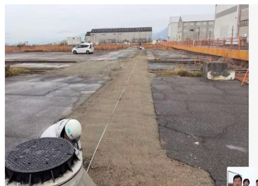
<遠隔実地検査（検査員の映像）>
