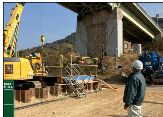
<遠隔実地検査（現場側）>
