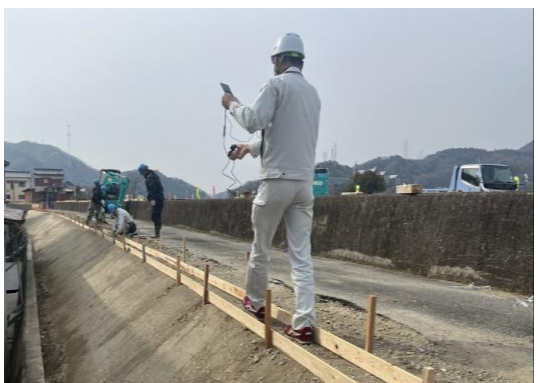
< 遠隔実地検査（現場側） >
