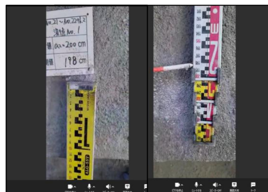
<遠隔実地検査（検査員の映像）>
